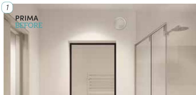
Nella sequenza di esempio è rappresentato il caso di un foro per l'impianto di aspirazione realizzato in posizione critica, troppo a ridosso dell'angolo del muro e con griglia circolare tagliata per poter esser installata.
