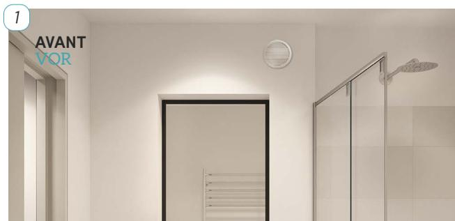
L'exemple représente le cas d'un trou pour l'installation d'aspiration réalisée dans une position critique, trop contre l'angle du mur et avec la grille circulaire coupée pour pouvoir être installée.
